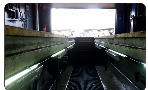
Exemple de solution LINE LIGHT solution montée dans une fosse de réparation de camions
